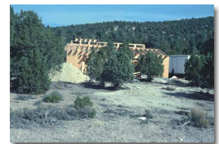
2X6 stud framing
