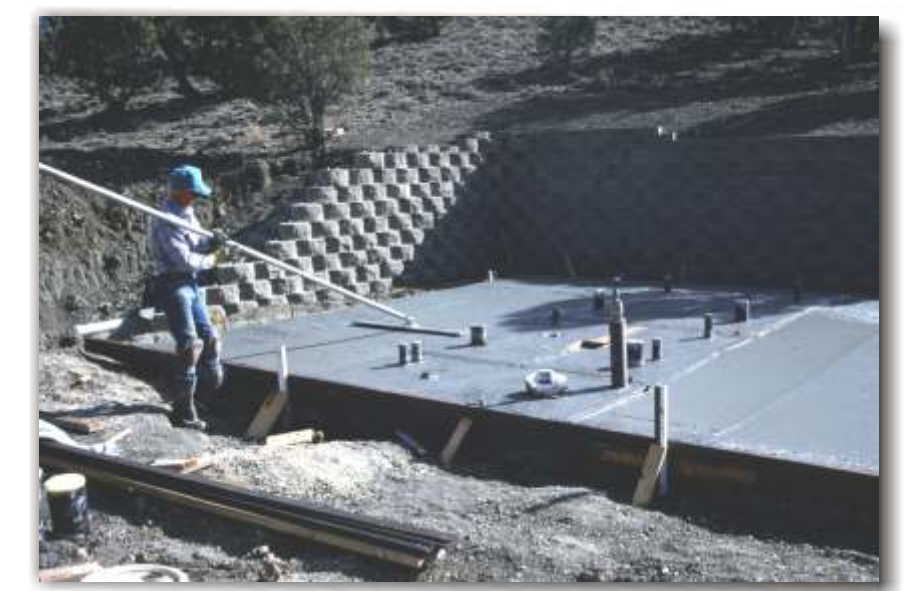
Concrete slab pour
